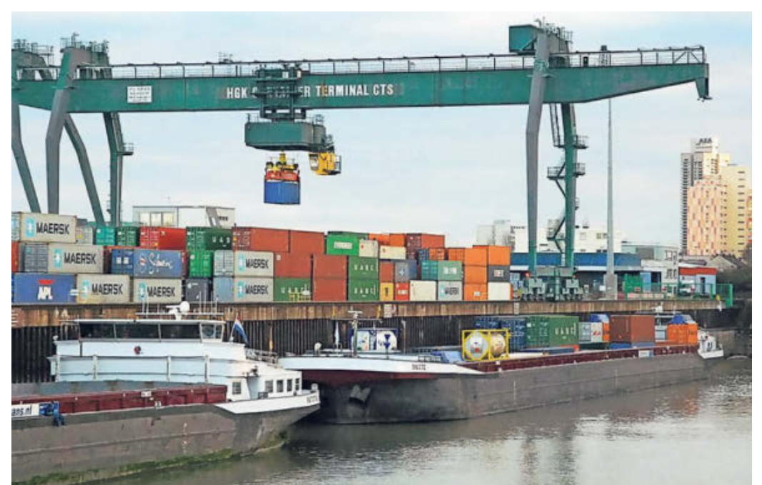
Der Kölner Containerhafen in Niehl.
